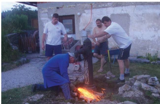
Odstranjevanje vaške pipe, gre v obnovo.
